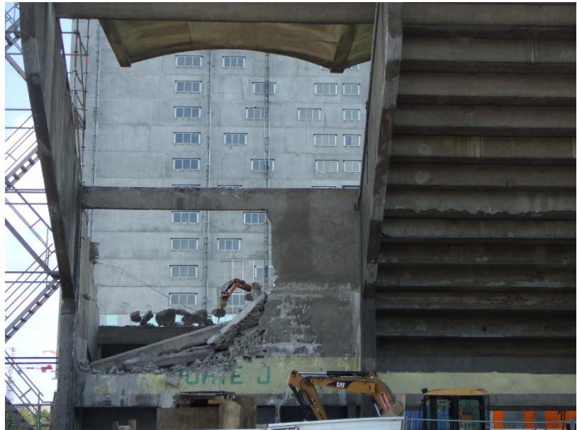
Juin 2008, déconstruction de Saupin (Architecte Camille Robida, 1937)
