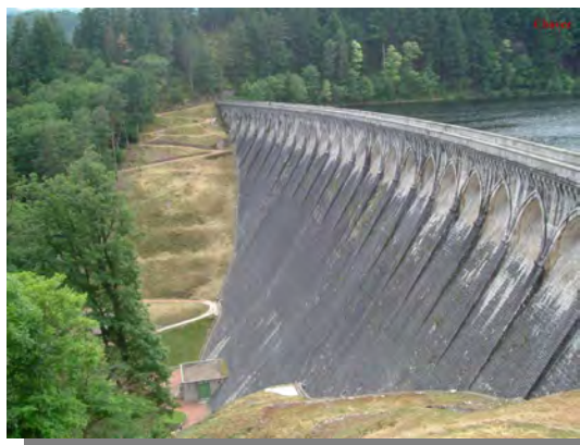
Barrage de ROANNE
