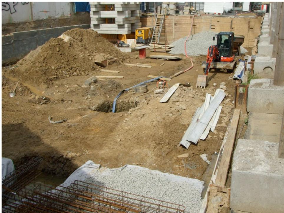
**Figure 2 : Situation au 7 mars 2011 : Installation de pompage et mise à sec du chantier (baisse du niveau supérieur de la nappe). Le système de pompage court sur le fond de l'excavation**
