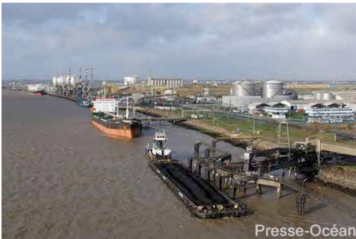
Terminal Charbonnier de Montoir
