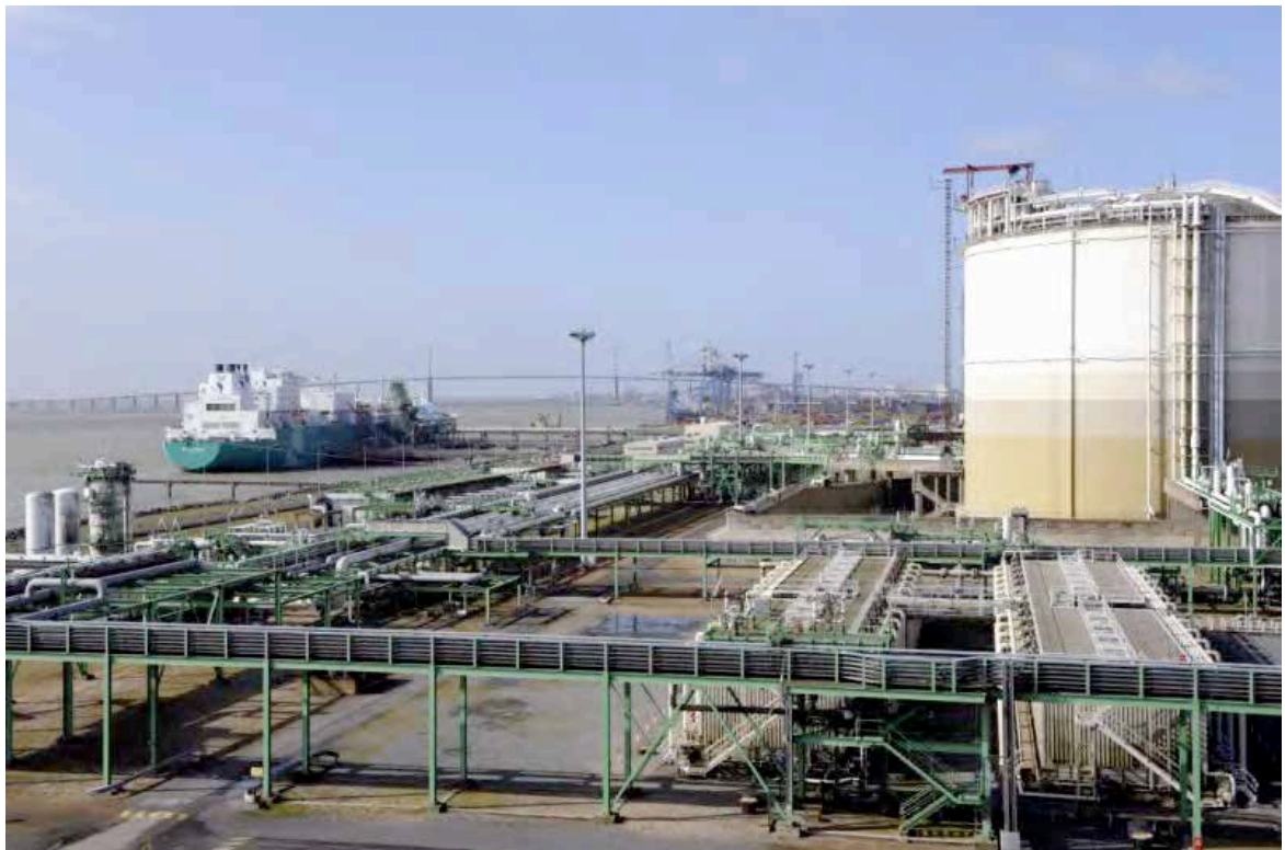
Terminal Méthanier de Montoir
