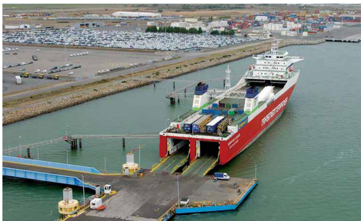
Terminal Ro Ro de Montoir
