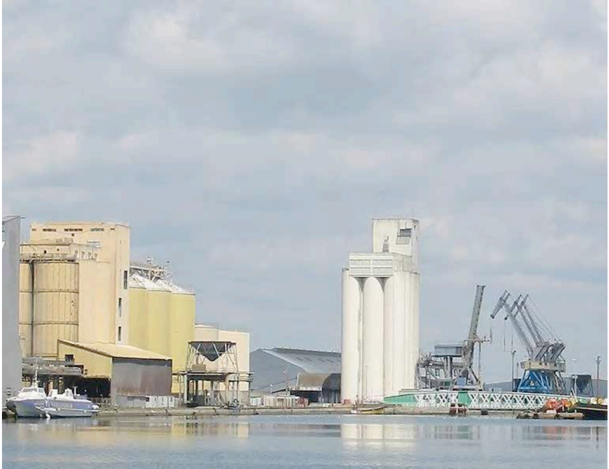
Silos à grains du bassin de Saint-Nazaire
