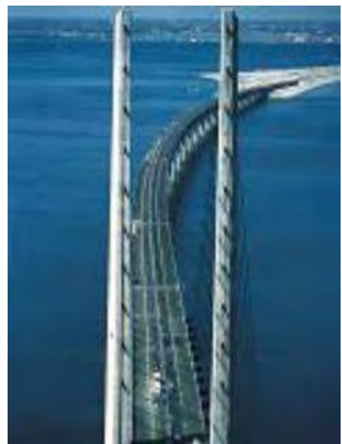
Pont-tunnel d'Oresund (Suède –Danemark)
